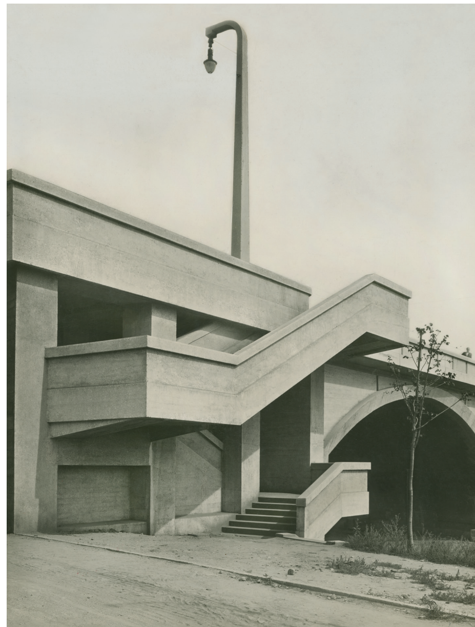
Schodiště přiléhající k levé straně Libeňského mostu. Kompletní konstrukce. Snímek pořízen v roce 1928. Národní technické muzeum, Muzeum architektury a stavitelství, 085/kt.014
