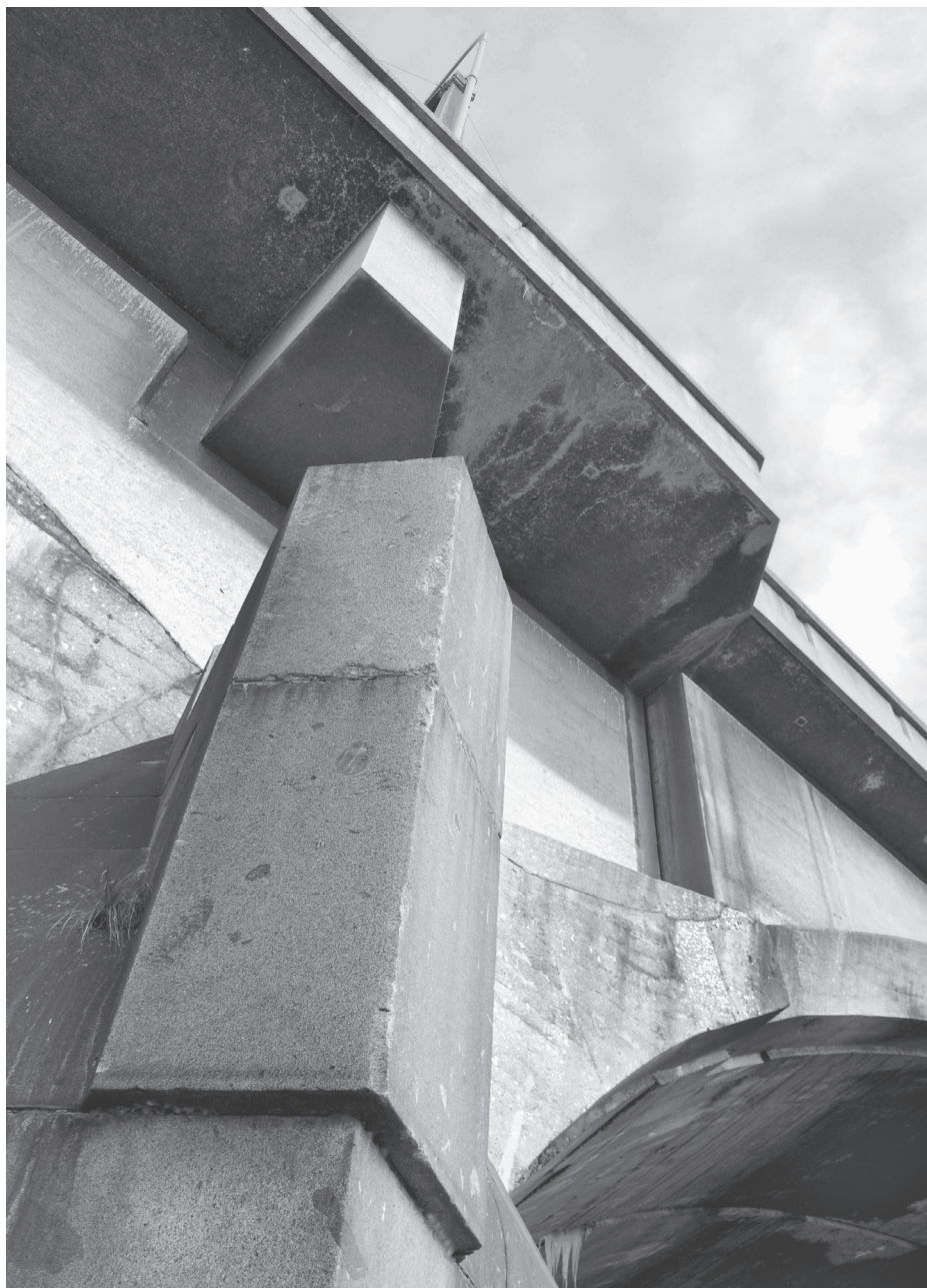
Detail kamenného obložení návodní strany pilíře, r. 2016
