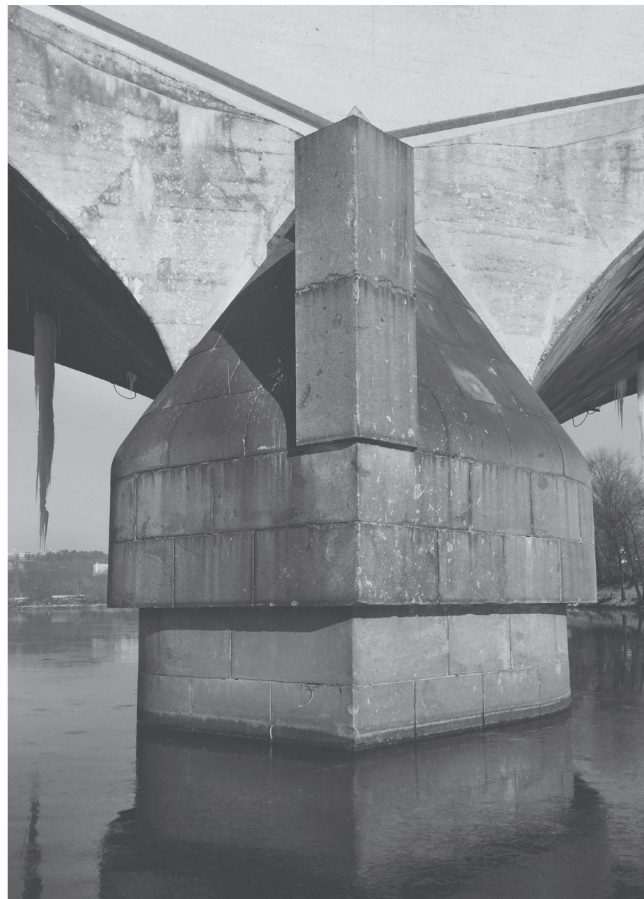
Detail kamenného obložení návodní strany pilíře, r. 2016
