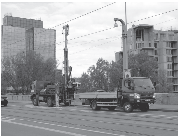
Hloubkové jádrové vrty do pilíře, základu až do podloží délky až 15 m.
