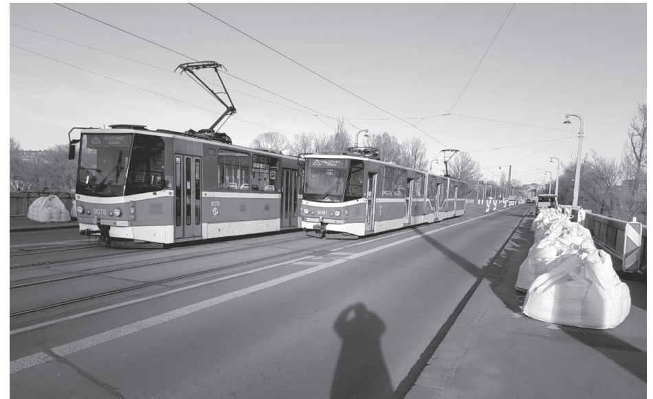
Asymetrické postavení tramvají do vrcholu oblouku z důvodu šikmosti mostu na oblouku a big bagy simulující chodce
