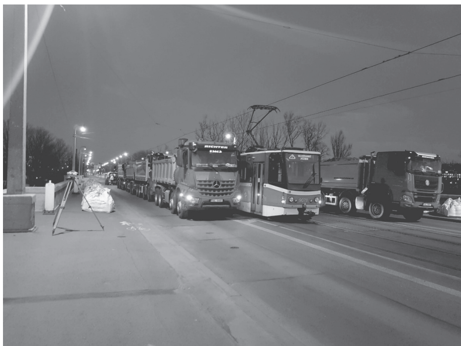
Plné zatížení oblouku 2. 2x tramvaj + 8x nákladní vůz a 34 big bagů
