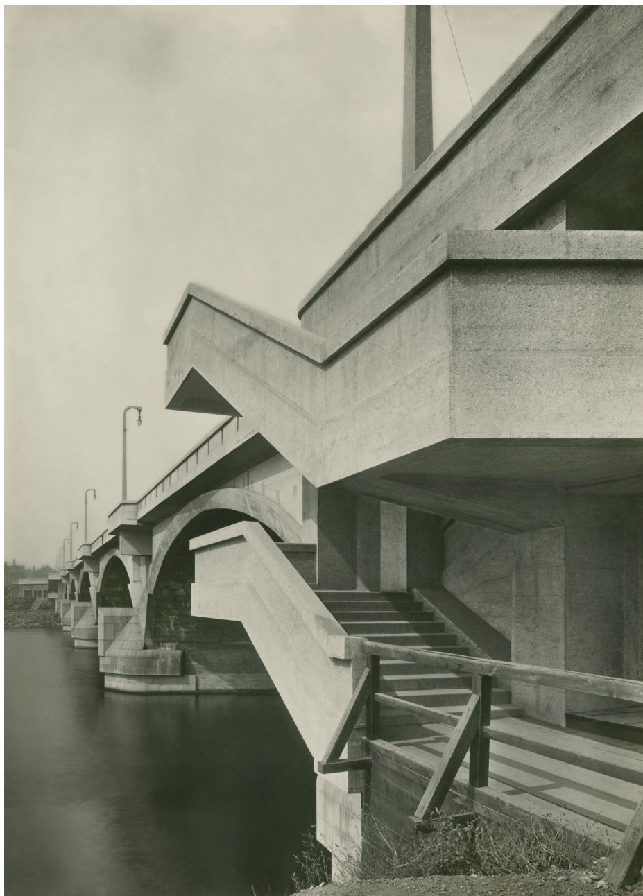
Detailní snímky konstrukce mostního schodiště Libeňského mostu. Snímek pořízen v roce 1928. Národní technické muzeum, Muzeum architektury a stavitelství, 085/kt.014
