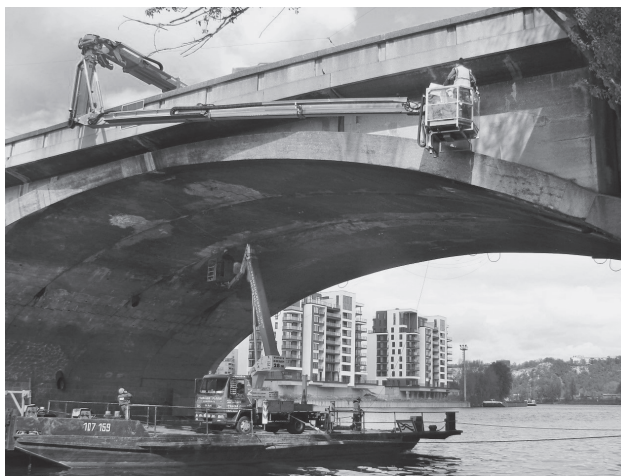
Provádění diagnostiky mostu z pontonu a plošiny
