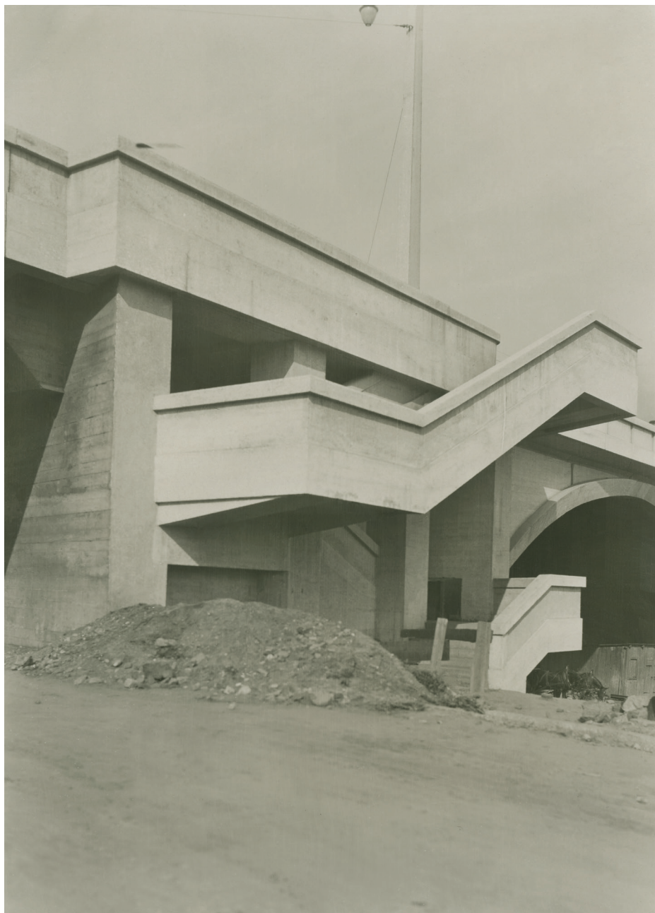
Schodiště při levé straně Libeňského mostu. Snímek pořízen v roce 1928. Národní technické muzeum, Muzeum architektury a stavitelství, 085/kt.014
