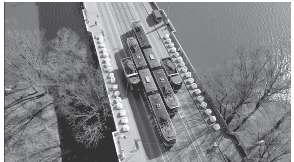
Postupné zatěžování oblouku 2. Pohled na rozmisťování břemen 2x tramvaj + 2x nákladní vůz a 34 big bagů
