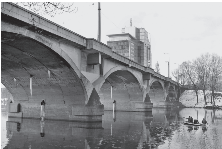
Celkový pohled na obloukovou část V009, r. 2016
