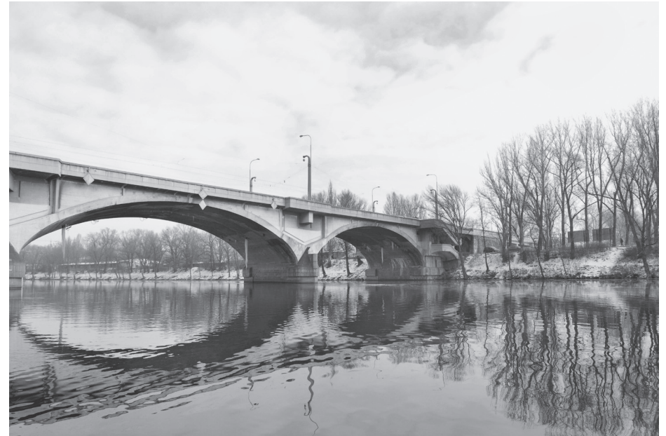
Celkový pohled na obloukovou část V009, r. 2016
