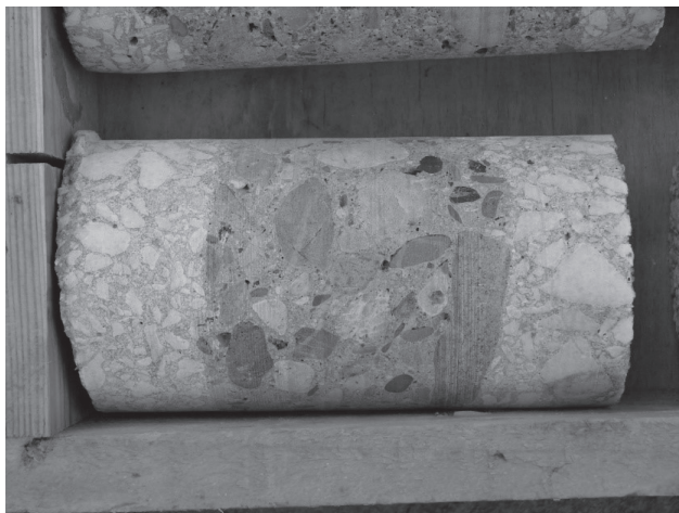
Jádrový vývrt beton zábradlí. Povrchy betonu zábradlí i poprsních stěn jsou tvořeny vrstvou betonu tzv. předsádkovým betonem. Povrchová vrstva 50–60 mm je tvořena z betonu s vápencovým (mramorovým) kamenivem a je vysoce odolná (XF4).
