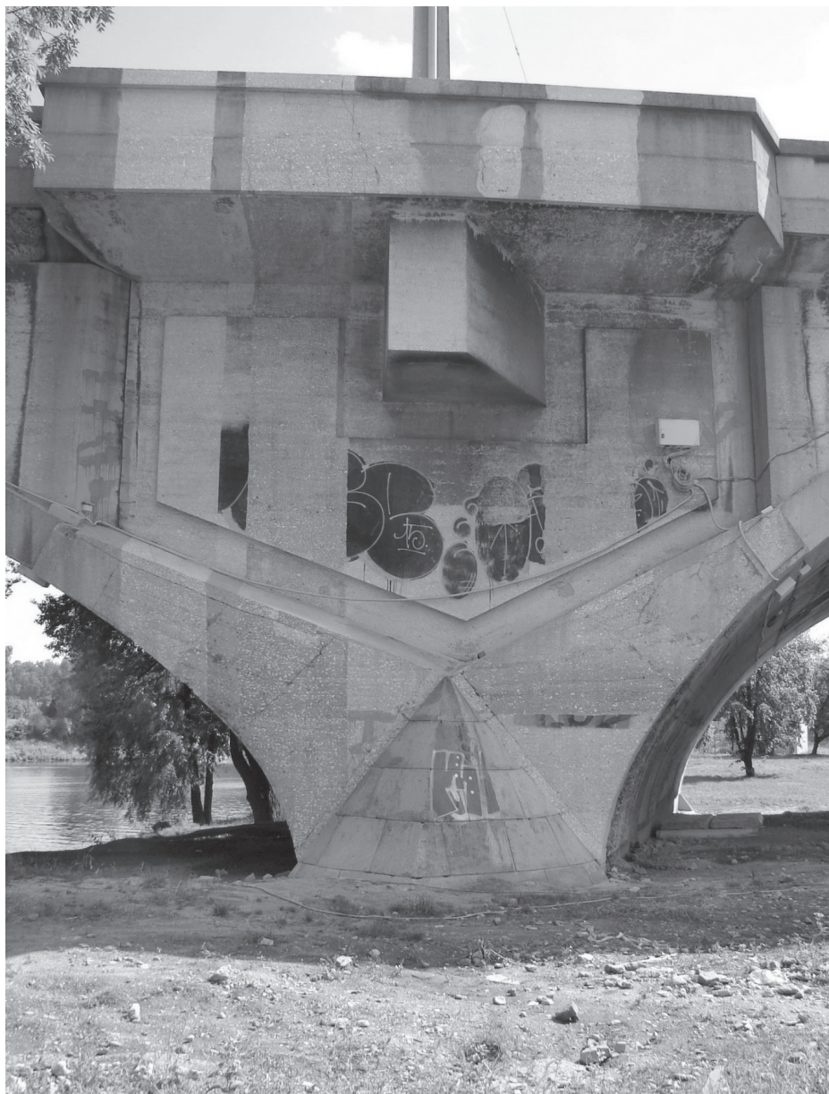
V rámci prací byly ověřovány i postupy opravy. Fotografie zaznamenává stav povrchů po čištění různými metodami tj. tlakovou vodou, vodní párou, nízkotlakým vlhkým pískováním.
