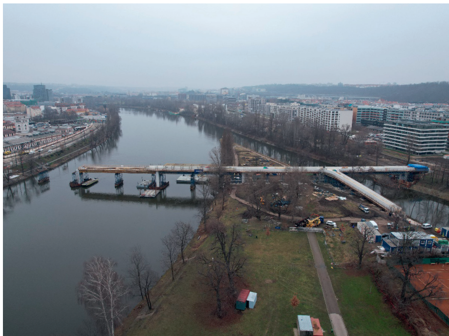
Pohled na rozestavěnou lávku – díky materiálu UHPFRC už vzniklo několik nových mostů ve Francii, Německu, Nizozemí i v Česku
