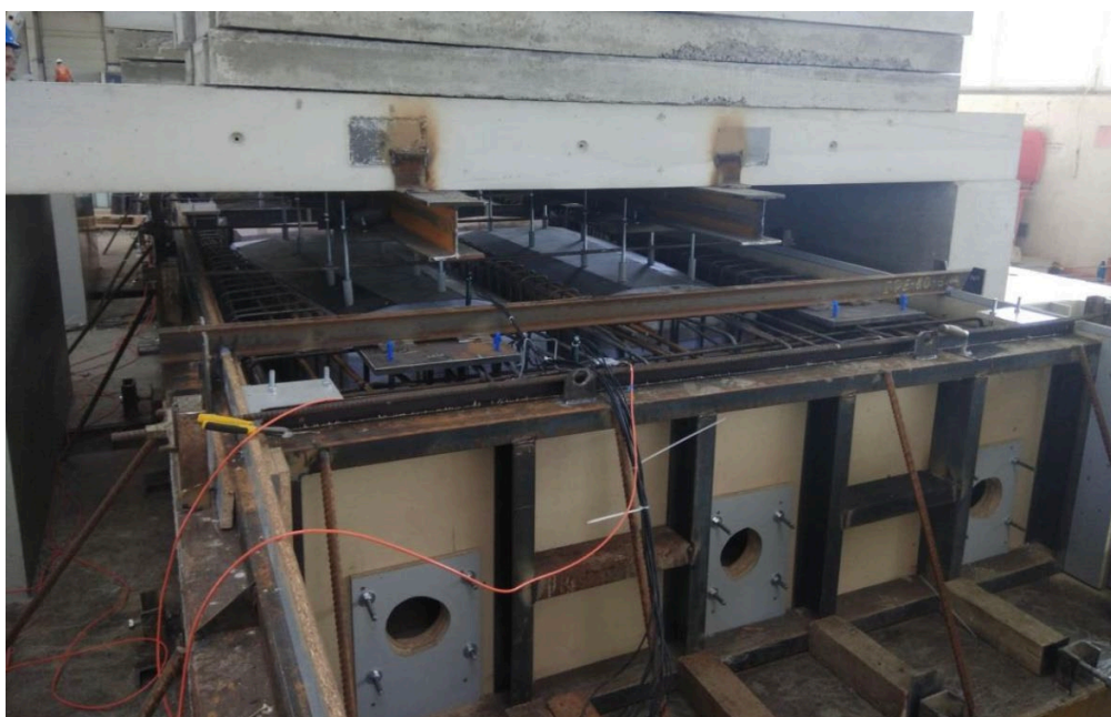
Obr. 5 Pohled na protizávaží s kotvením vylehčovacích polystyrenů a další zabudované prvky jako ložiska a manipulační pouzdra.
