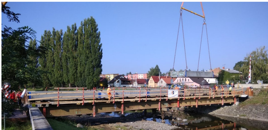
Obr. 6 Montáž segmentu S2 (čtvrtého v pořadí)
