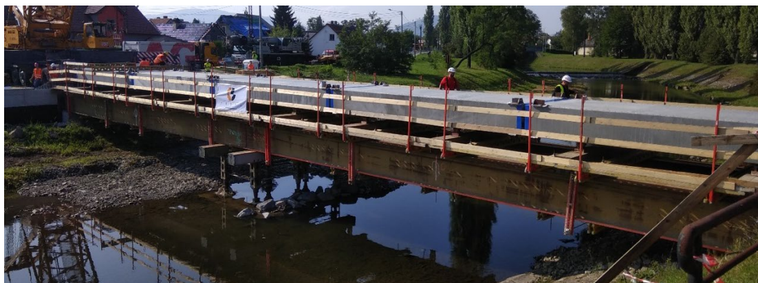
Obr. 8 Pohled na dokončenou montáž nosné konstrukce
