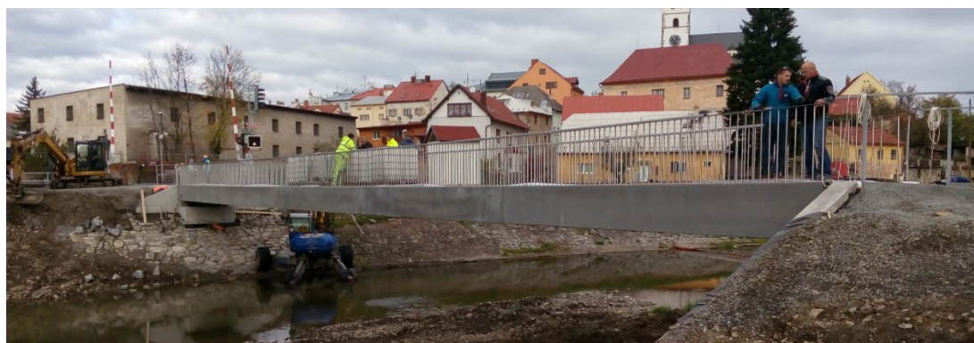
Obr. 9 Lávka v Příboře před dokončením
