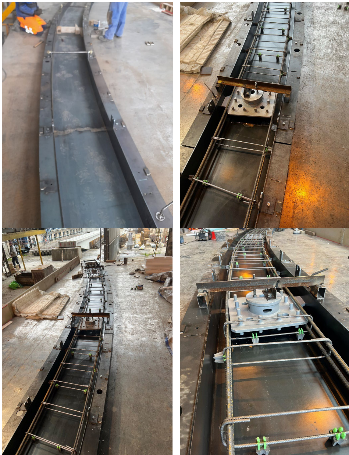
Obr. 4 Celoocelová forma
