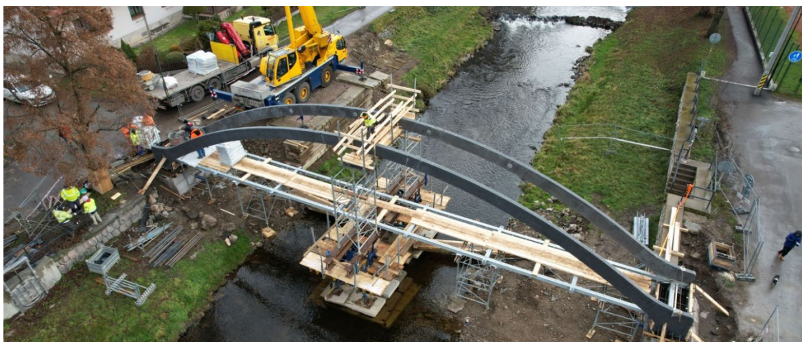
Obr. 15 Stav mostu po betonáži monolitických částí z UHPFRC
