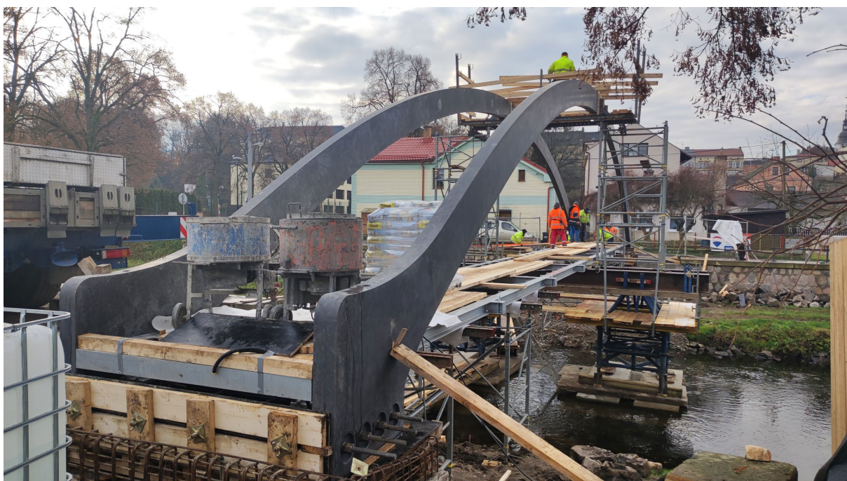
Obr. 13 Příprava na zmonolitnění
