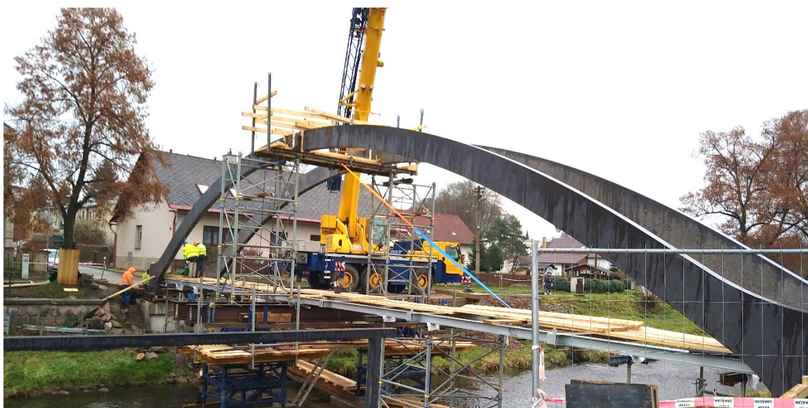
Obr. 11 Osazené všechny 4 poloviny oblouků
