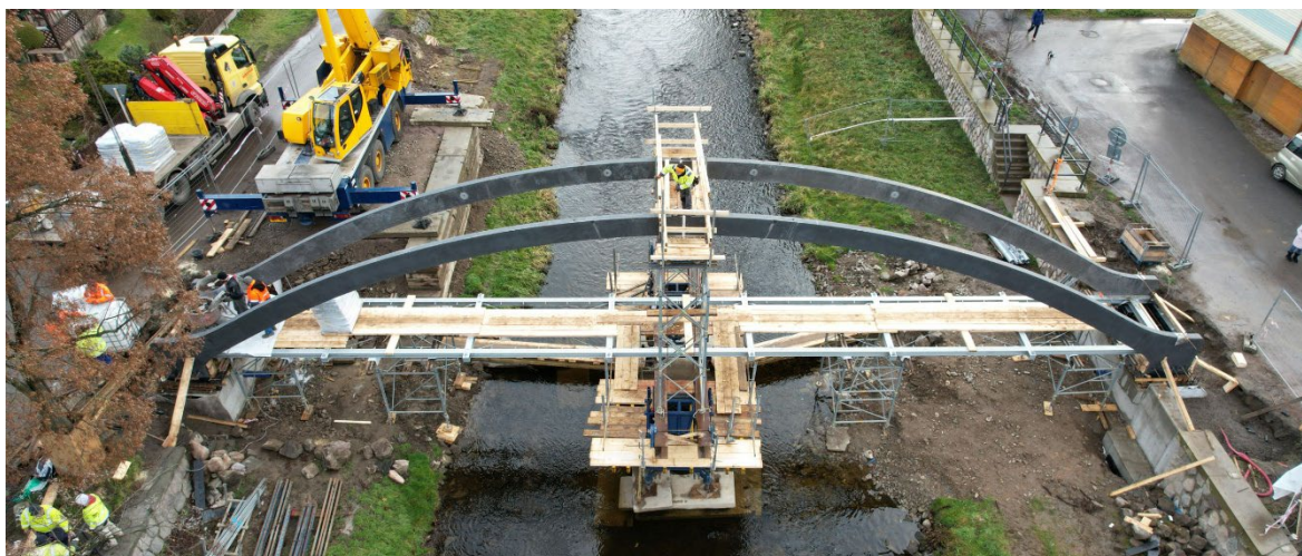
Obr. 14 Stav mostu po betonáži monolitických částí z UHPFRC
