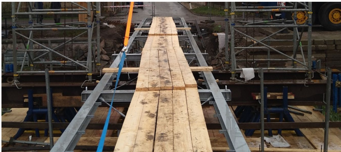
Obr. 9 Pohled na osazenou nosnou část mostovky
