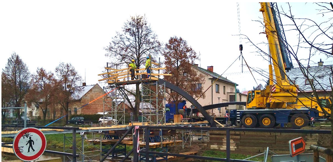
Obr. 10 Osazení první poloviny prvního oblouku
