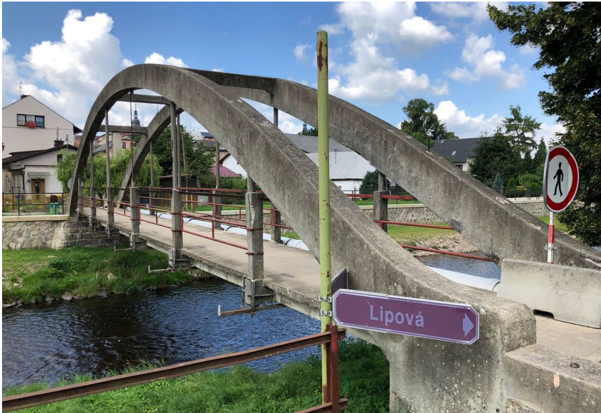
Obr. 1 Původní betonový most
