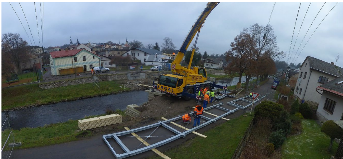
Obr. 8 Předmontáž mostovky
