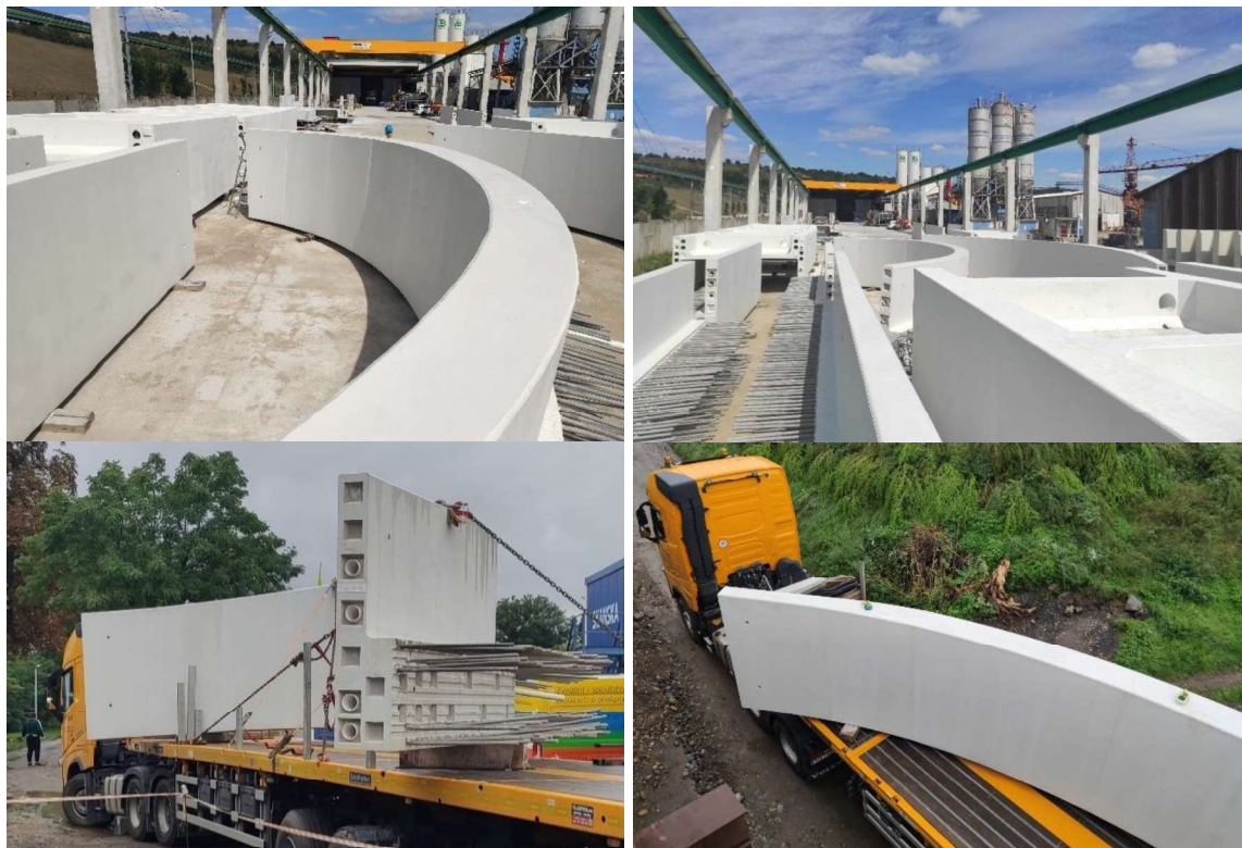
Obr. 10 Prefabrikáty parapetů na skládce a na stavbě
