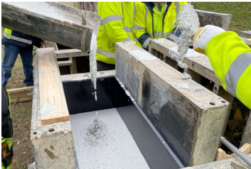
Obr. 12 Zkušební tělesa a zpracovatelnost betonu
