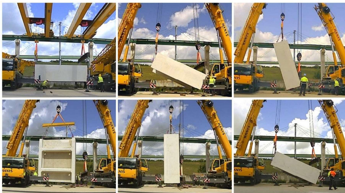
Obr. 9 Otáčení segmentu pomocí dvojice jeřábů
