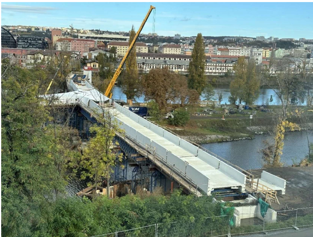
Obr. 17 Segmenty 1. a 2. taktu osazené na pevné skruži: pohled z Karlína
