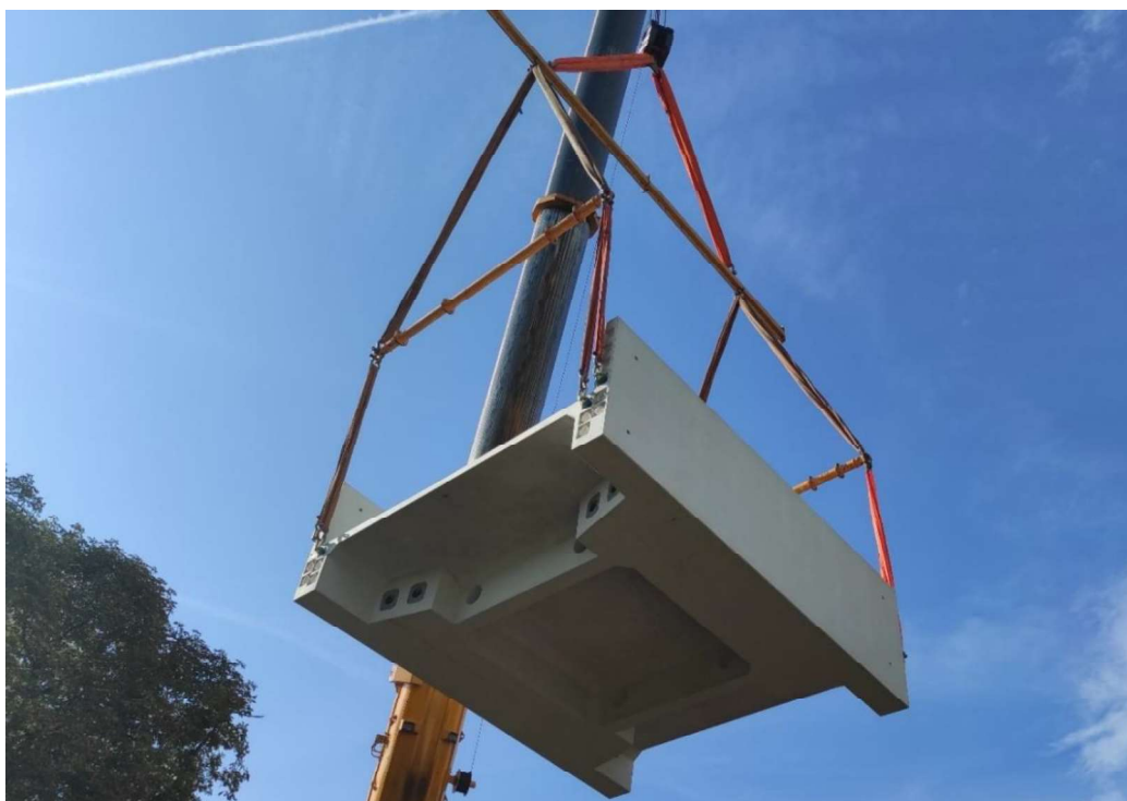
Obr. 8 Segment zavěšený na systému vahadel na stavbě
