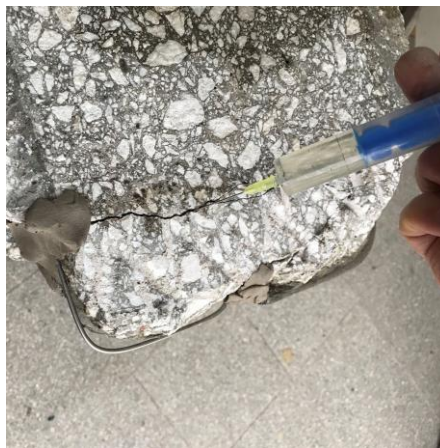
obr.58. Zainjektování nízkoviskózní epoxidovou pryskyřicí Injektionsharz 100 (fa Remmers)
