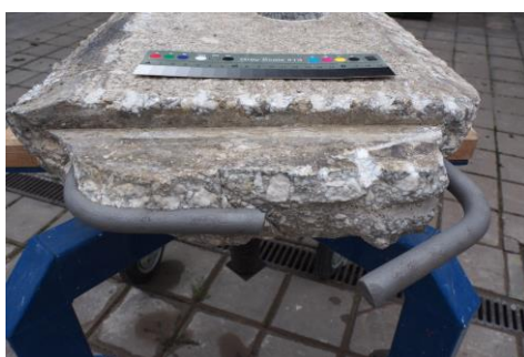
obr.61. Ošetření armatur adhezním můstkem s konzervačním účinkem ( Rostschutz EP, Betofix RM fa Remmers )
