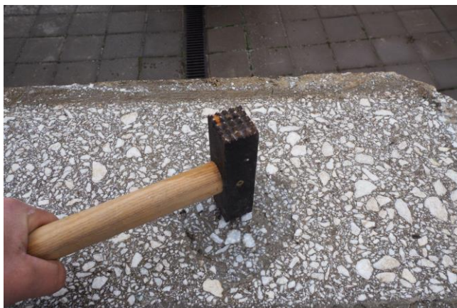
obr.70. Pemrlování povrchu
