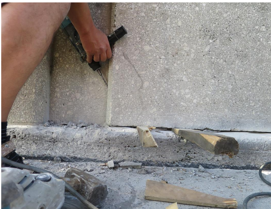
obr.22. Dobourávání částí spárové malty ze svislého zámku, podklínování výplně
