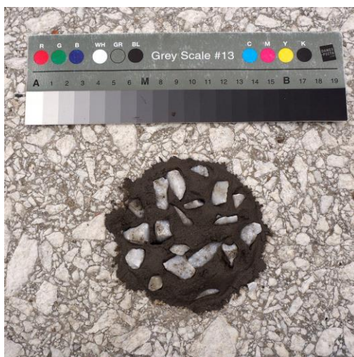
obr.66. Proces tmelení
