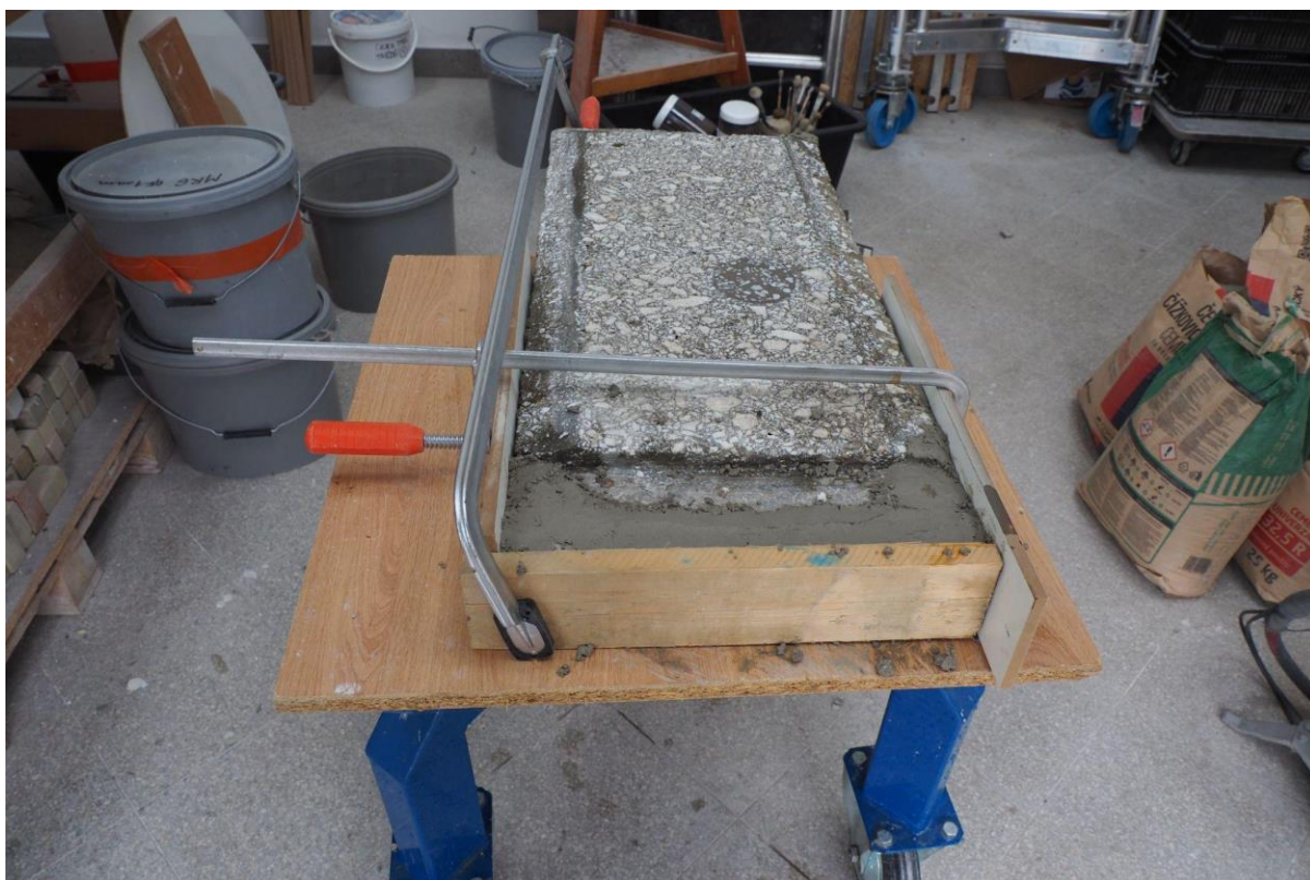
obr.72. tmelení větších konstrukčních nepohledových částí
