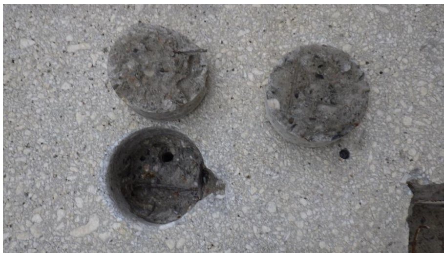
obr.27. Bližší pohled provedené vývrty – jádrový beton a betonářská výztuž
