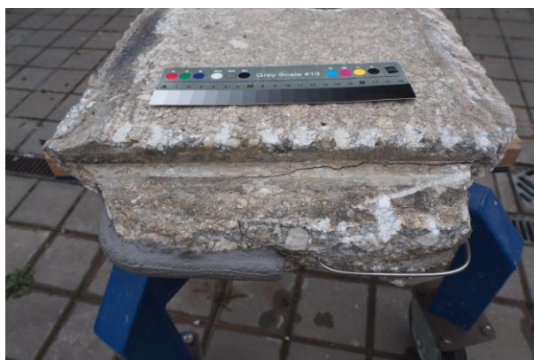
obr.64. Vlepení nerezové armatury o průměru 4 mm pomocí epoxidového tixotropního lepidla ( Akepox 5010 Akemi ).
