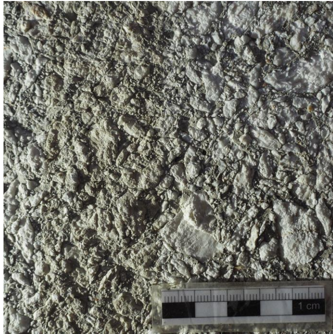
obr.55. Čištění horkou tlakovou vodou 130 bar / 130 °C
