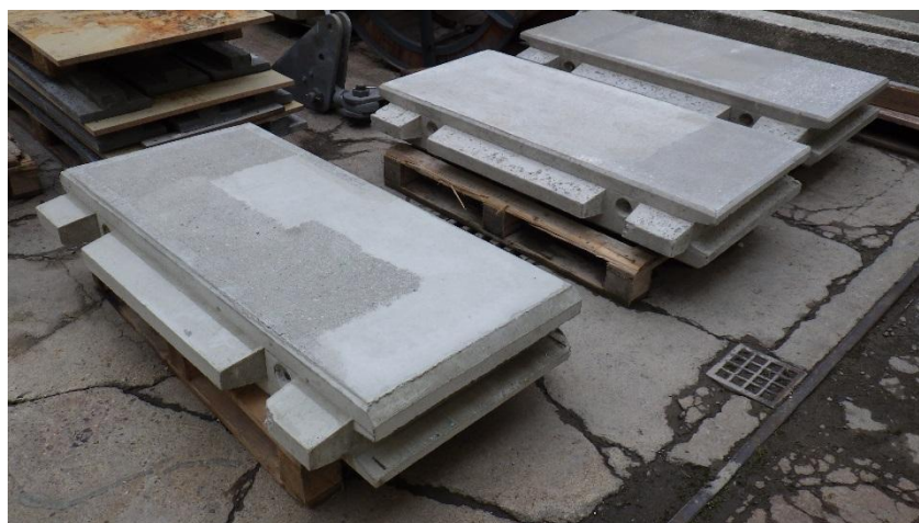
obr.44. Vzorok replik prefabrikátu zábradelního panelu na dvoře KÚ ČVUT v Praze
