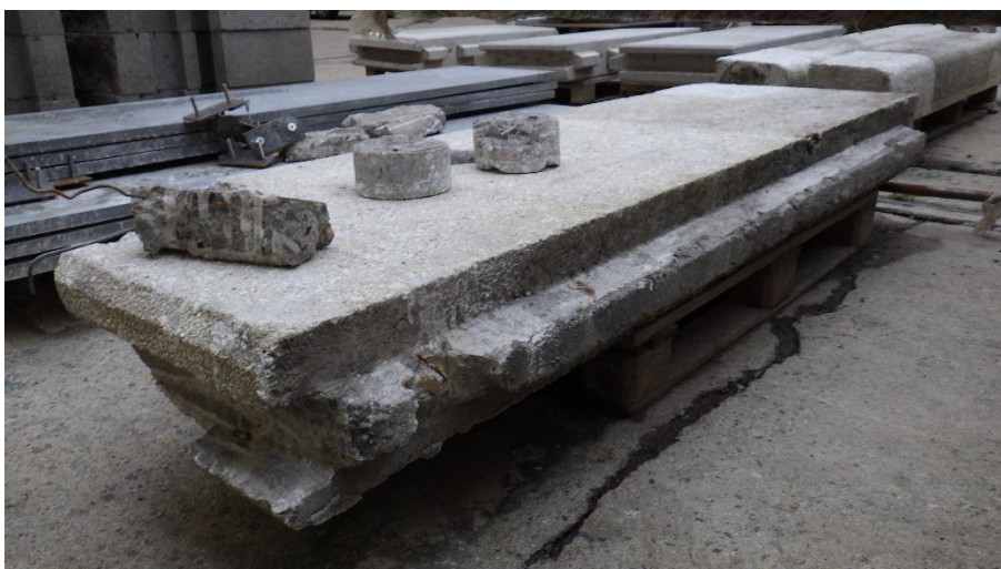
obr.30. Pohled na druhou podélnou stranu panelu – návaznost spojovací drážky a pera
