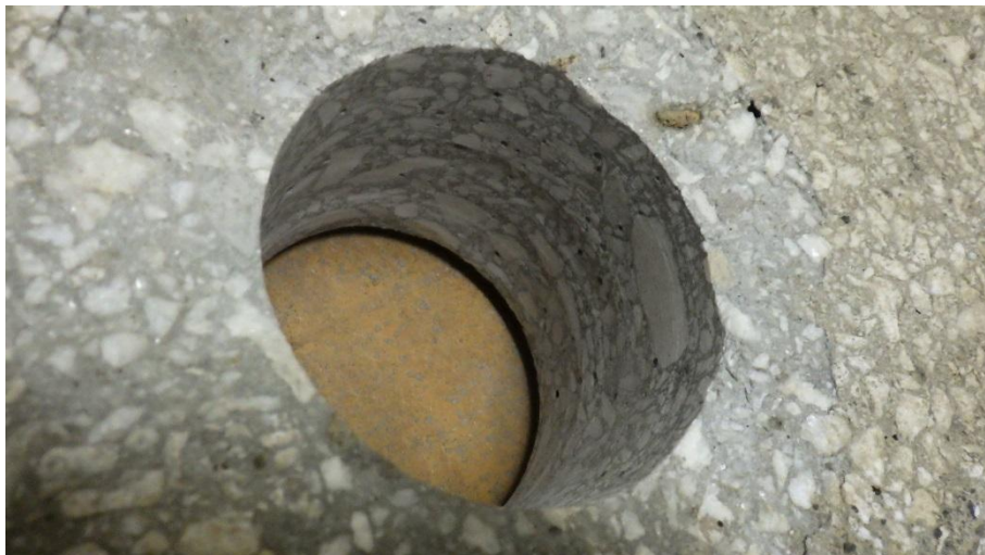
obr.32. Bližší pohled do provedeného vývrtu – předsádkový beton
