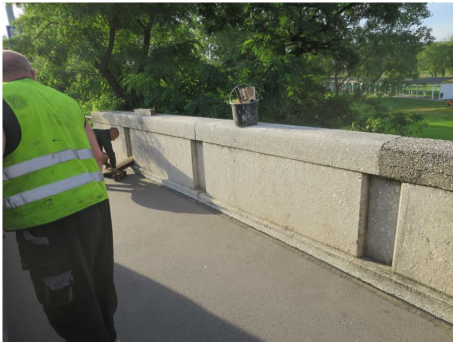
obr.16. Referenční část zábradlí před zahájením rozebírání
