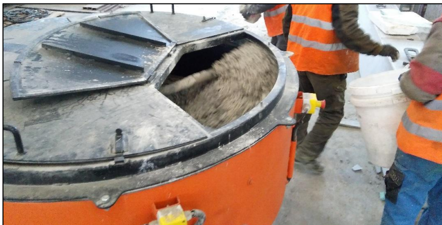
obr.37. Míchání betonové směsi
