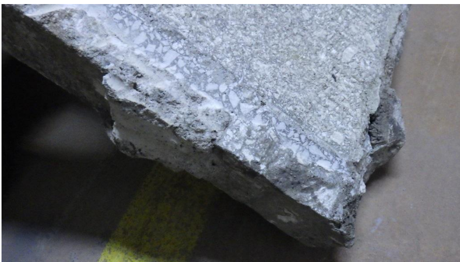
obr.33. Detail zbytků cementového tmele ve stycích
