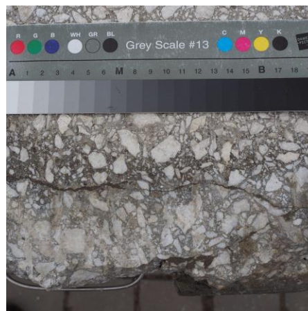
obr.59. Zaplnění povrchu jemnou minerální reprofilační maltou Betofix RM2 (fa Remmers)
