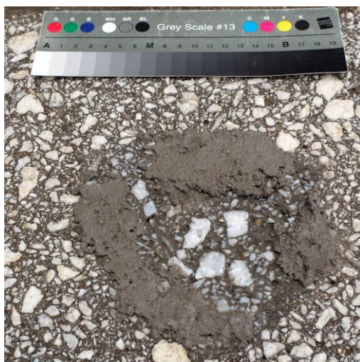
obr.67. Proces tmelení
