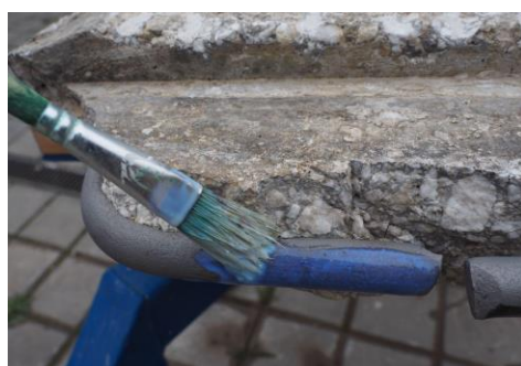
obr.62. Ošetření armatur adhezním můstkem s konzervačním účinkem ( Rostschutz EP, Betofix RM fa Remmers )
