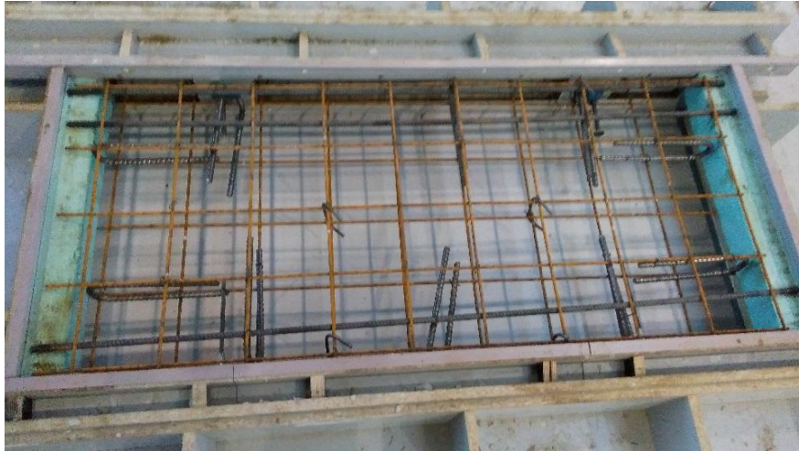
obr.36. Pohled do bedně – formy s osazenou výztuží
