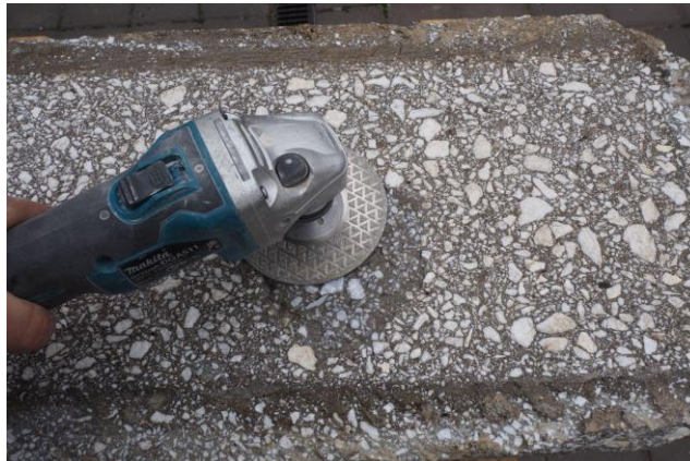
obr.69. Broušení povrchu diamantovým kotoučem
