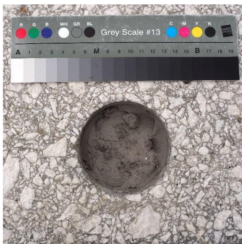
obr.65. Proces tmelení
