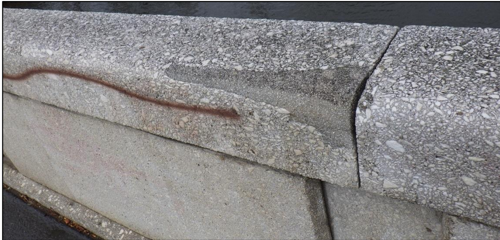
obr.13. Příklad rozdílného vzhledu povrchů desek, spodního proužku u chodníku madel pravděpodobně s velmi starou vysprávkou
