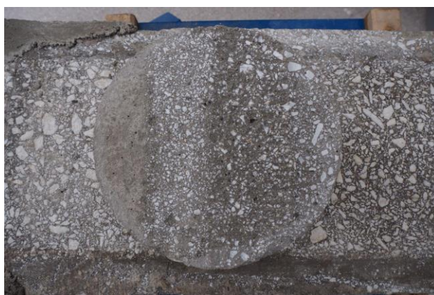
obr.71. Ukázka fází povrchové úpravy: 1. povlak cementového pojiva po nanesení 2. jehlování 3. pemrlování 4. broušení diamantovým kotoučem
