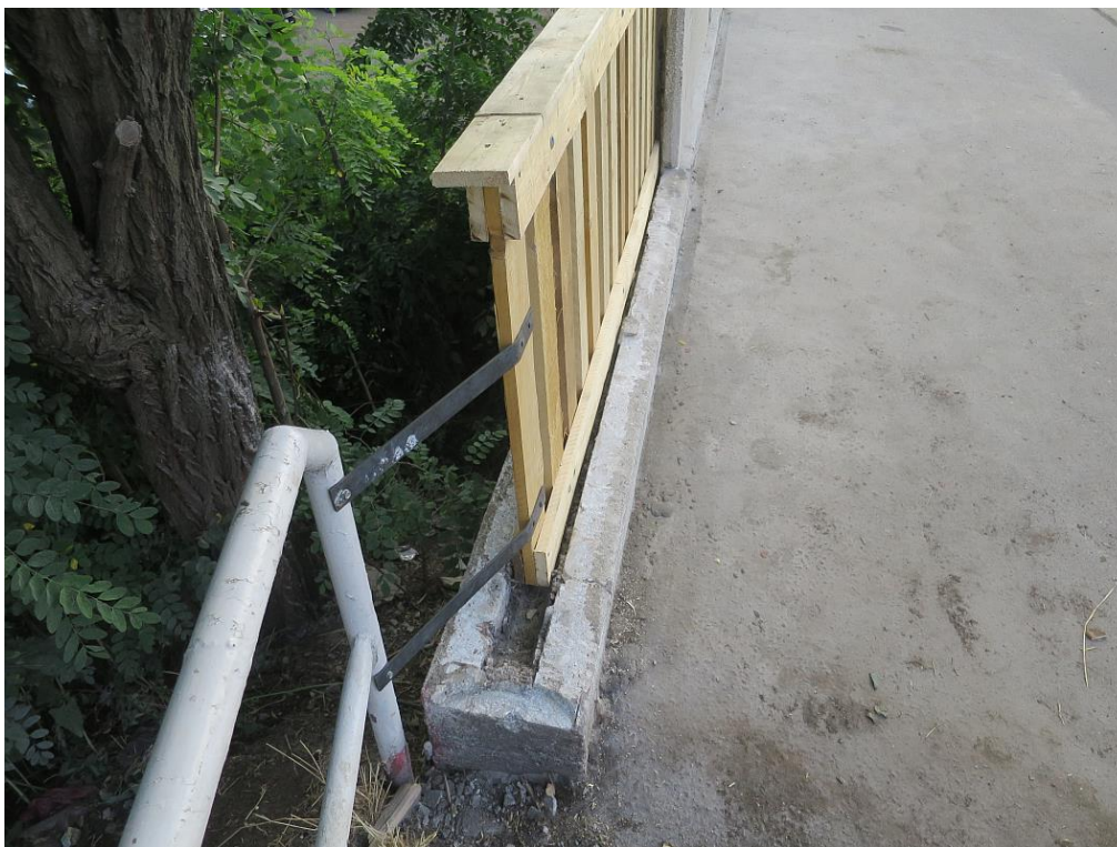
obr.25. Po dohodě se správcem objektu bylo zábradlí doplněno panelem vyrobeným z řeziva.
