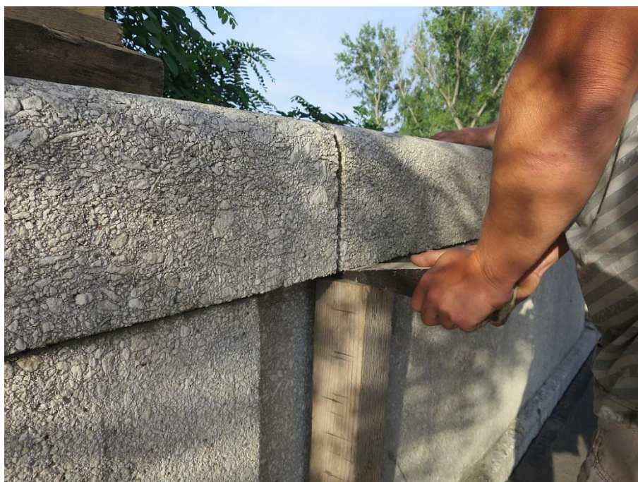
obr.17. K uvolnění madel byly použity dřevěné klínky
