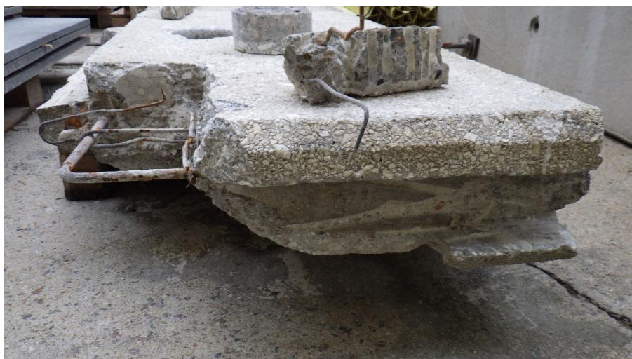
obr.29. Pohled na boční stranu panelu – drážku pro spojení se sloupkem
