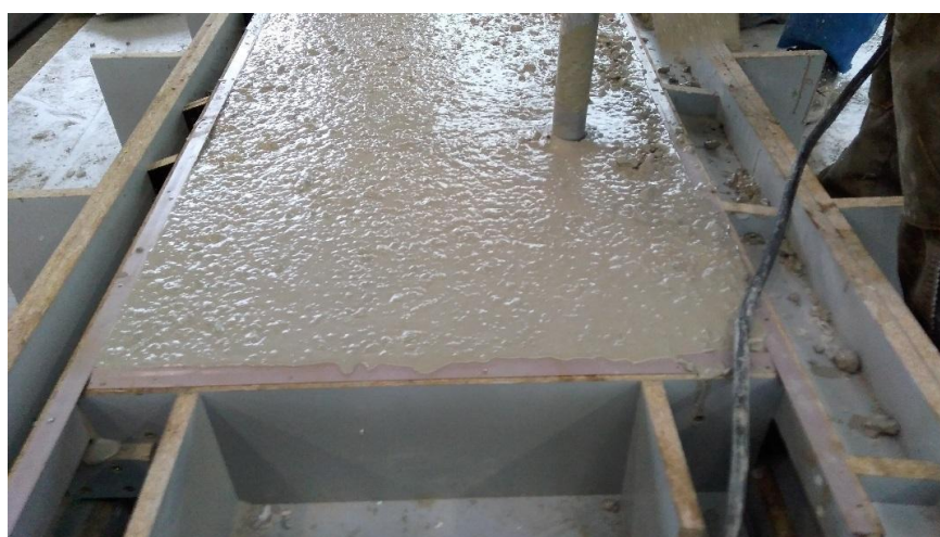
obr.38. Hutnění uložené směsi ponornou vibrací
