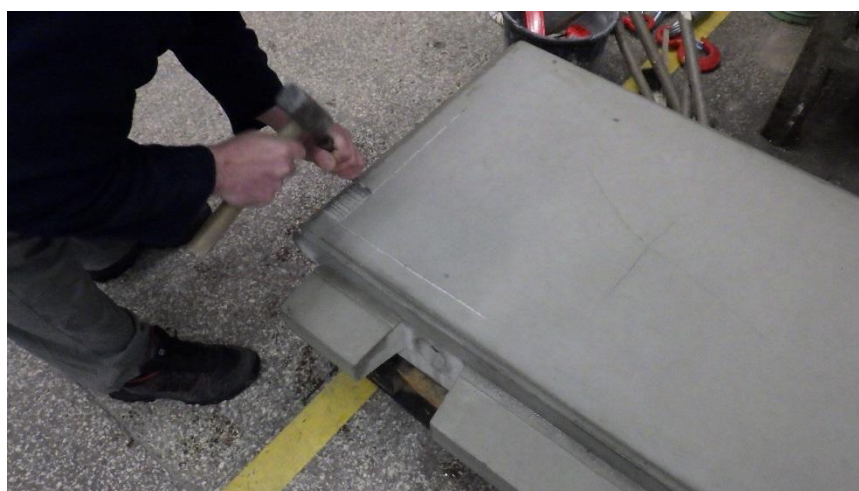
obr.41. Ruční provedení páskování podél hrany panelu
