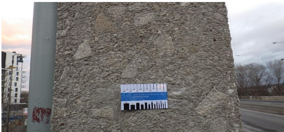
obr.6. Příklad hrubozrného plniva – drti s patinou stávajícího stavu povrchu na kandelábru
