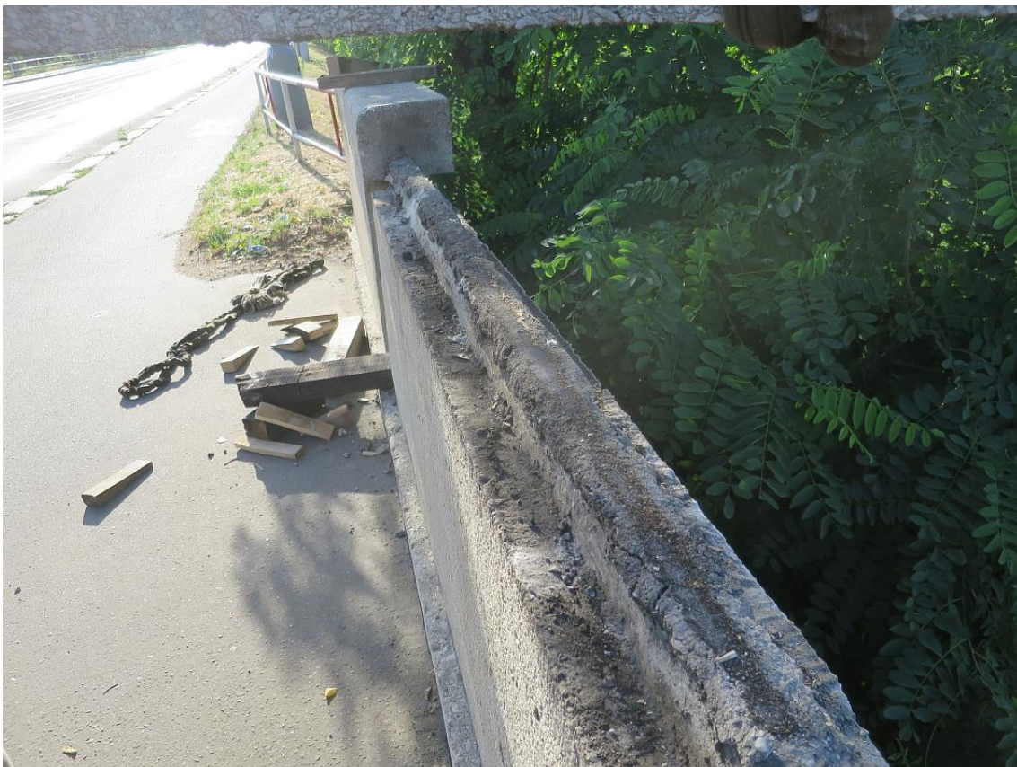
obr.20. Detail horního pera výplně
