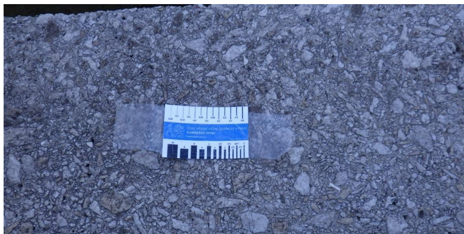
obr.7. Příklad středně hrubého plniva – přirozeně vymyté drti na horní ploše madla
