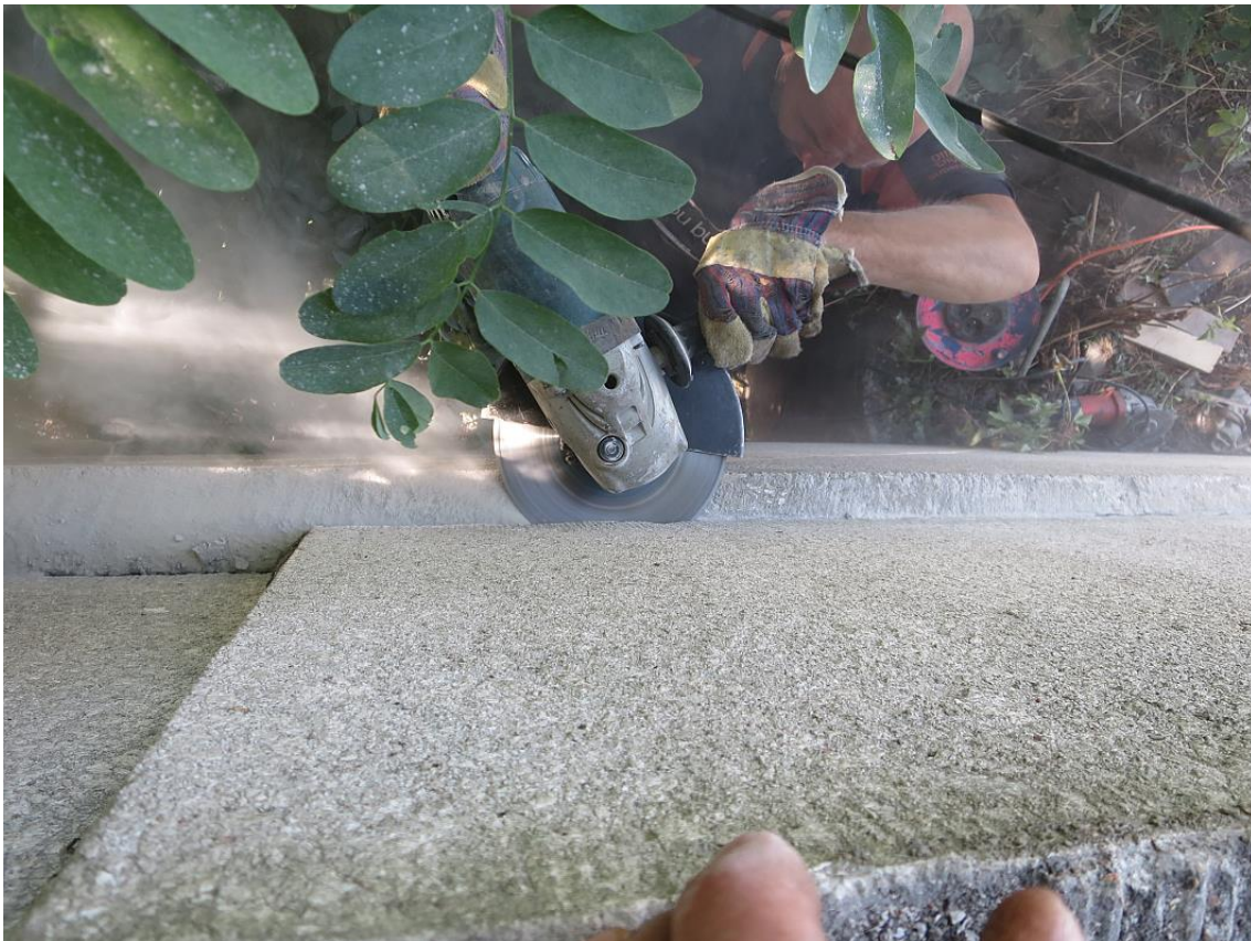
obr.21. Prořezávání spodní spáry mezi výplní a římsou
