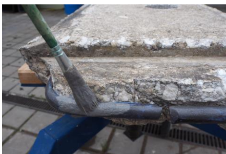
obr.63. Ošetření armatur adhezním můstkem s konzervačním účinkem ( Rostschutz EP, Betofix RM fa Remmers )
