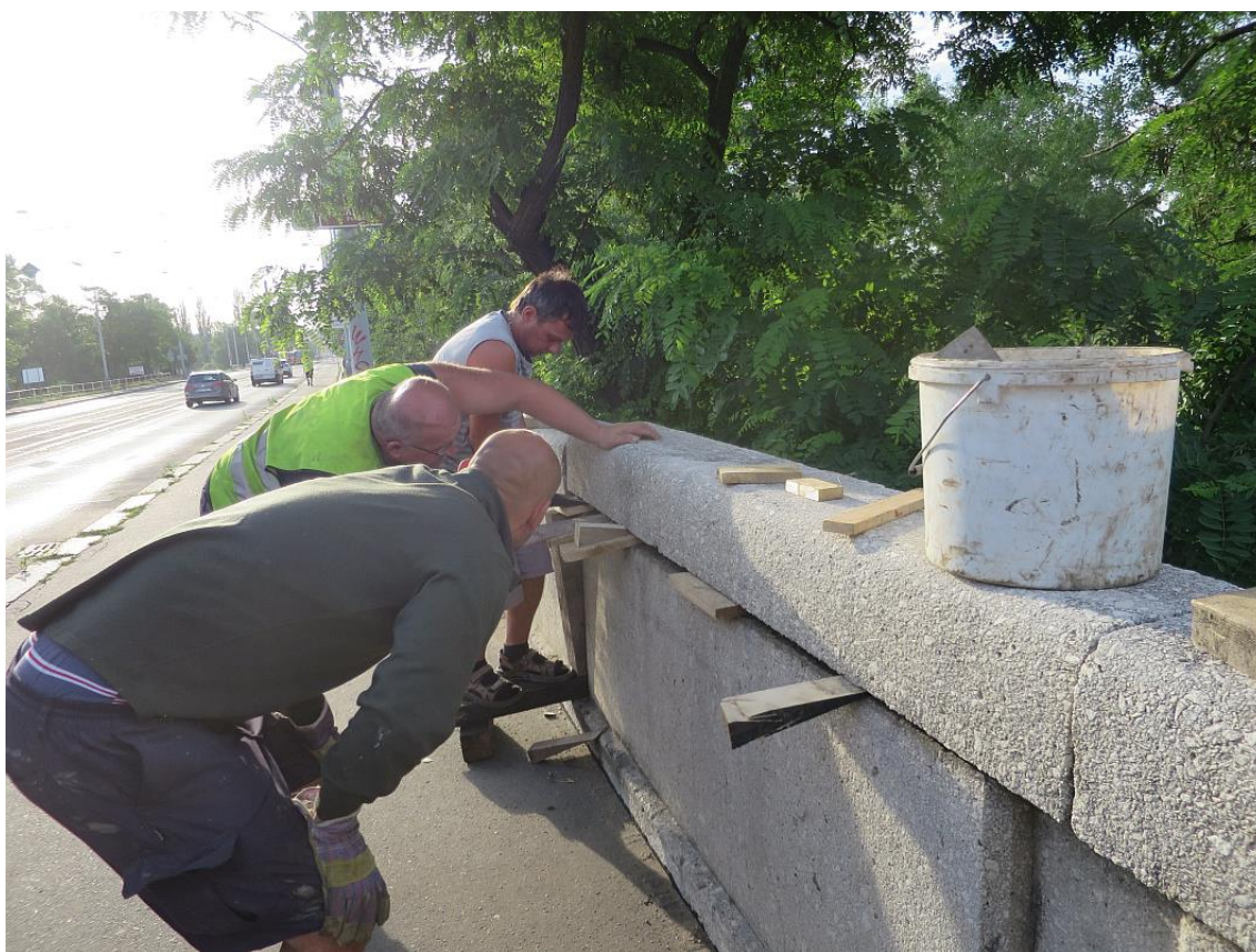
obr.18. Nadzvednutí madla pro protažení závěsů
